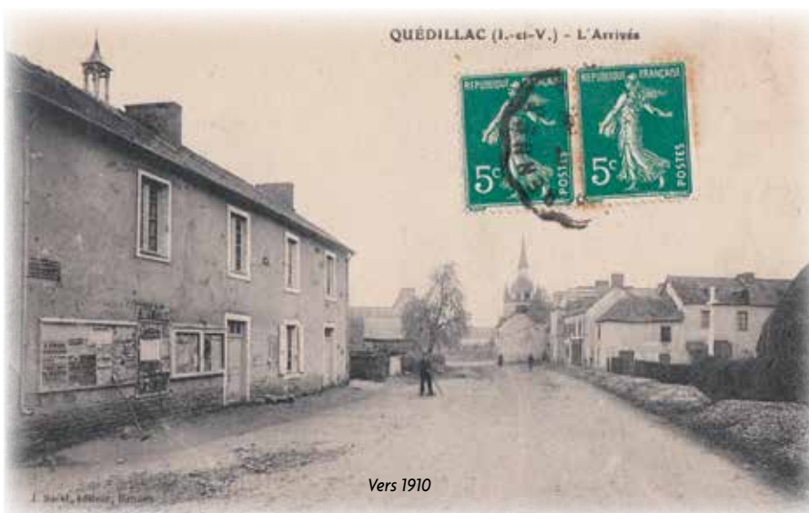
Observer les panneaux d'affichage bien garnis devant la mairie. Au-dessus du toit la présence d'un clocheton laisse également penser qu'on pouvait actionner la cloche depuis la classe située juste en-dessous.
