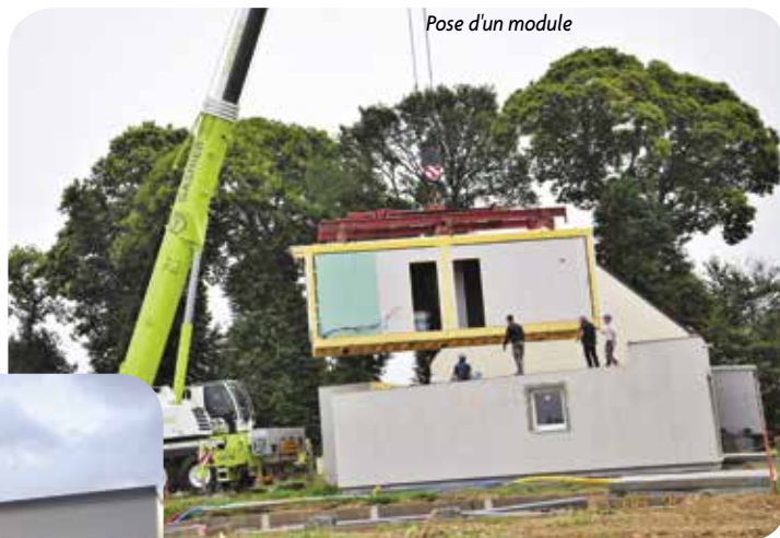
Pose d'un module
